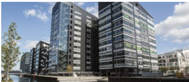
Havneholmen Tower, Köpenhamn
